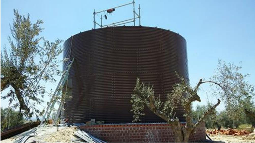
Sistema eficaz para la protección del acero, protege la chapa del contacto directo con el agua.
